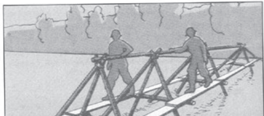
Rekonstruktion des Querschnitts des schwimmenden Seehindernisses an Hand der Zeitzeugenaussagen 165
